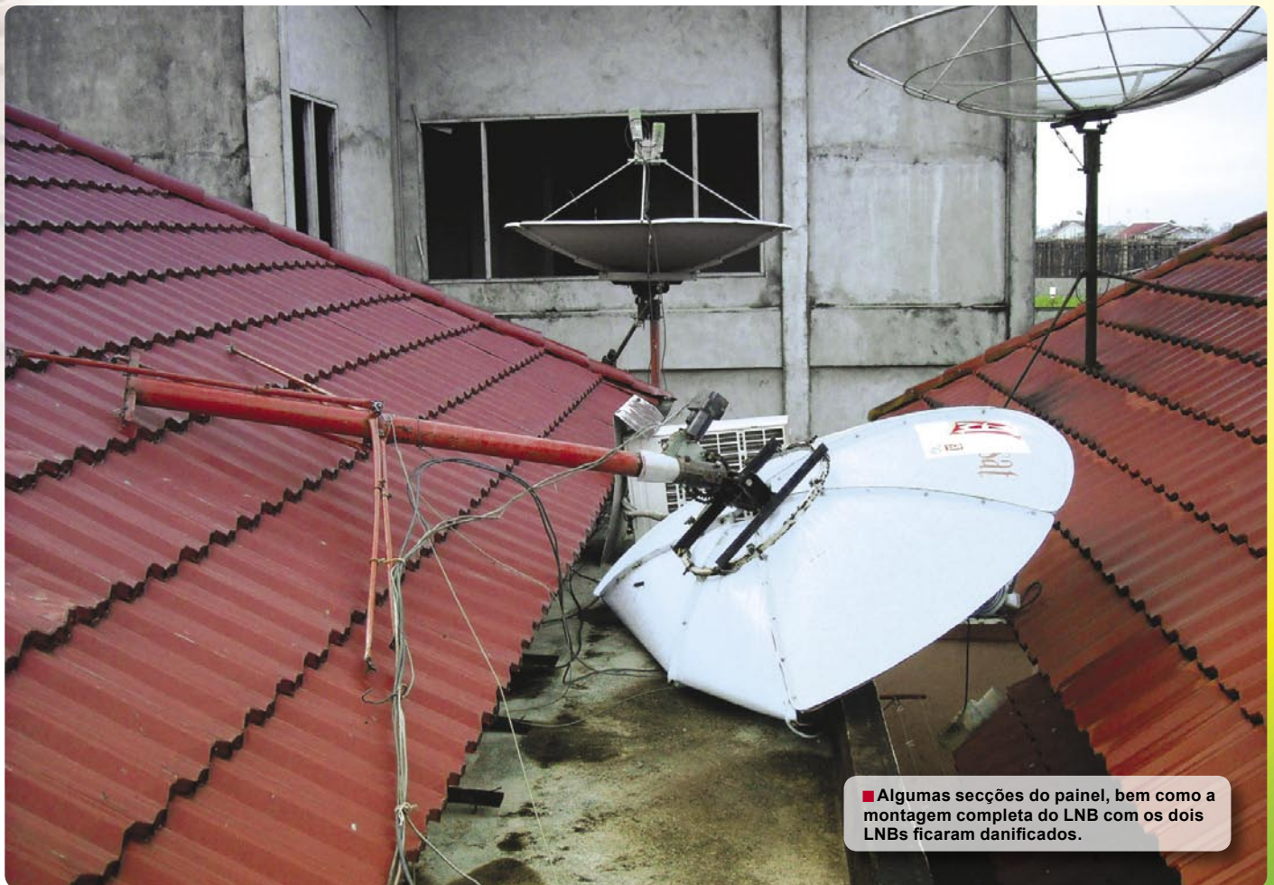
■ Depois: Que pena - o prato com 1,8 m desabou devido às altas cargas do vento.
